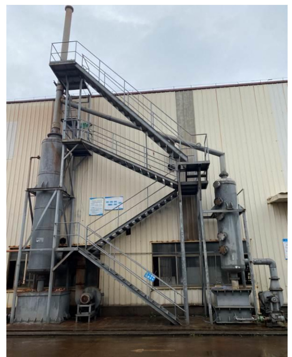
闪蒸干燥、粉碎、粉碎后包装粉尘等 废气处理设施
