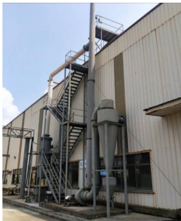
带式干燥、带式干燥后出料粉碎、包装粉尘等废气排放口（DA003）
