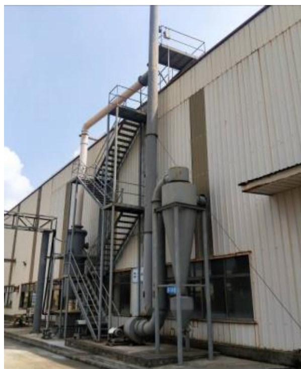
带式干燥、带式干燥后出料粉碎、包装粉尘等 废气处理设施
