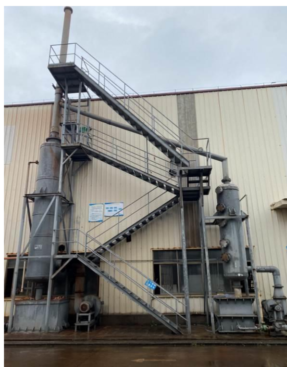
闪蒸干燥、粉碎、粉碎后包装粉尘等 废气处理设施
