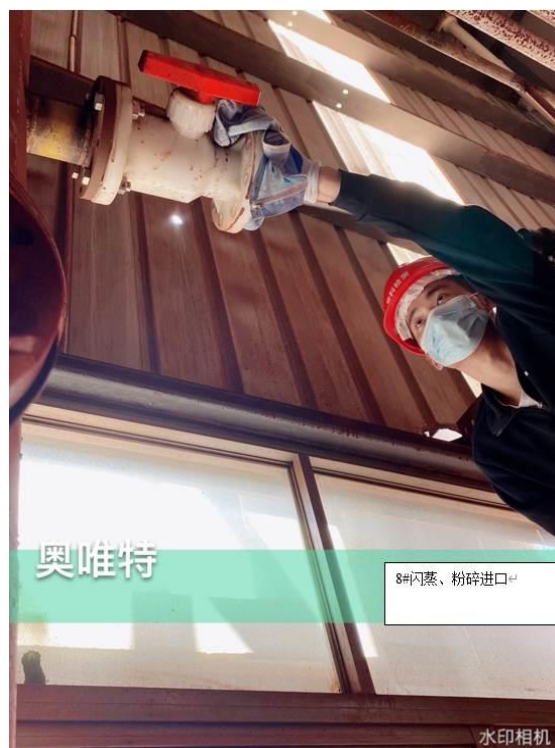
8#: 闪蒸干燥、粉碎等废气处理设施进口
