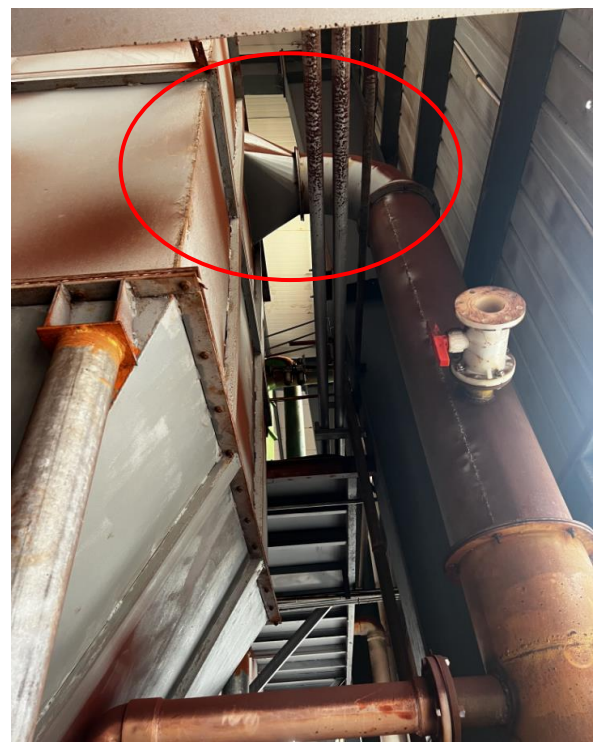
闪蒸干燥设备：产生点位密闭废气集气罩集气
