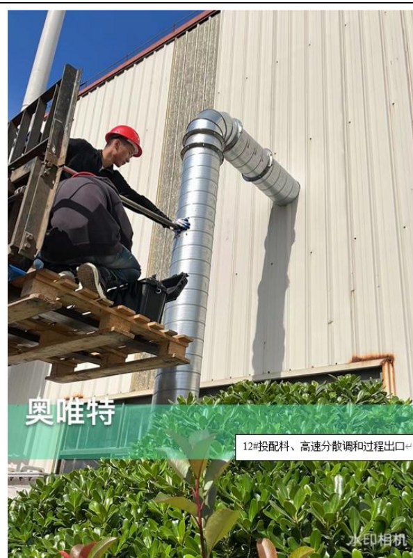
12#: 分散体车间投配料、高速分散、调和等废气处理设施出口 (DA005)
