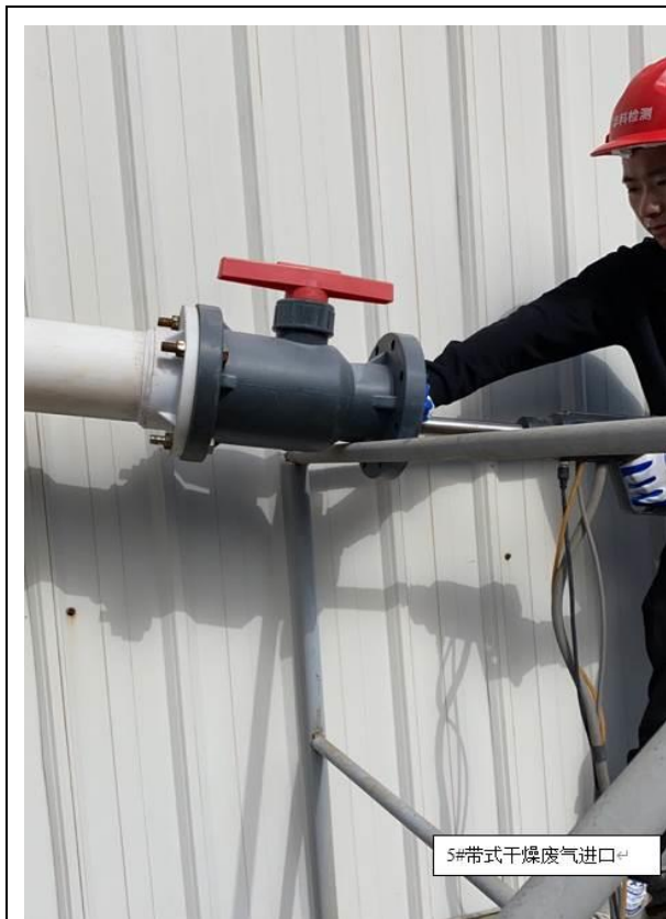
5#: 带式干燥粉尘废气处理设施进口
