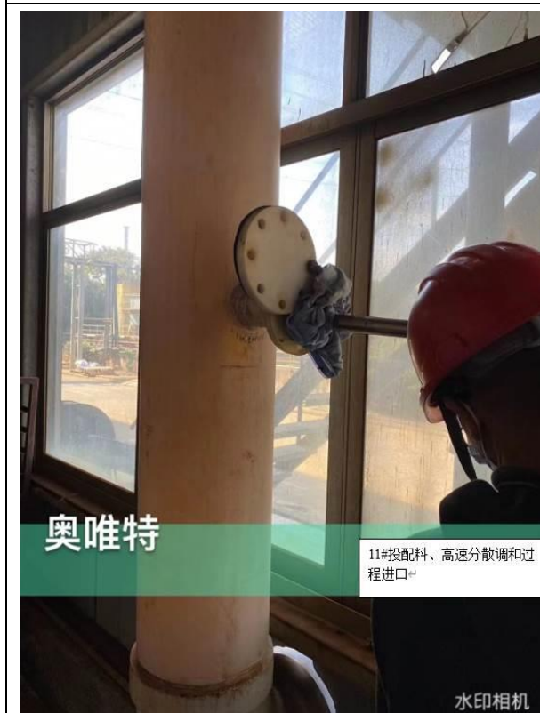
11#: 分散体车间投配料、高速分散、调和等废气处理设施进口 (活性炭吸附装置前端)
