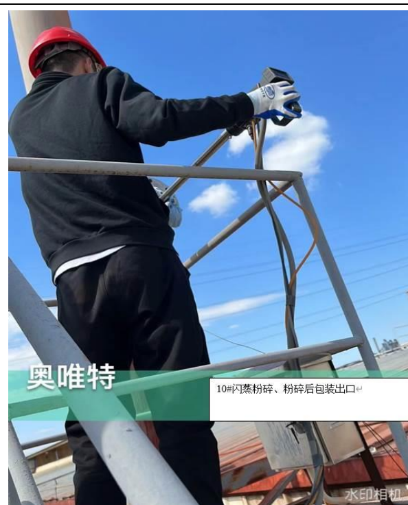
10#: 闪蒸干燥、粉碎、粉碎后包装等废气处理设施出口 (DA004)
