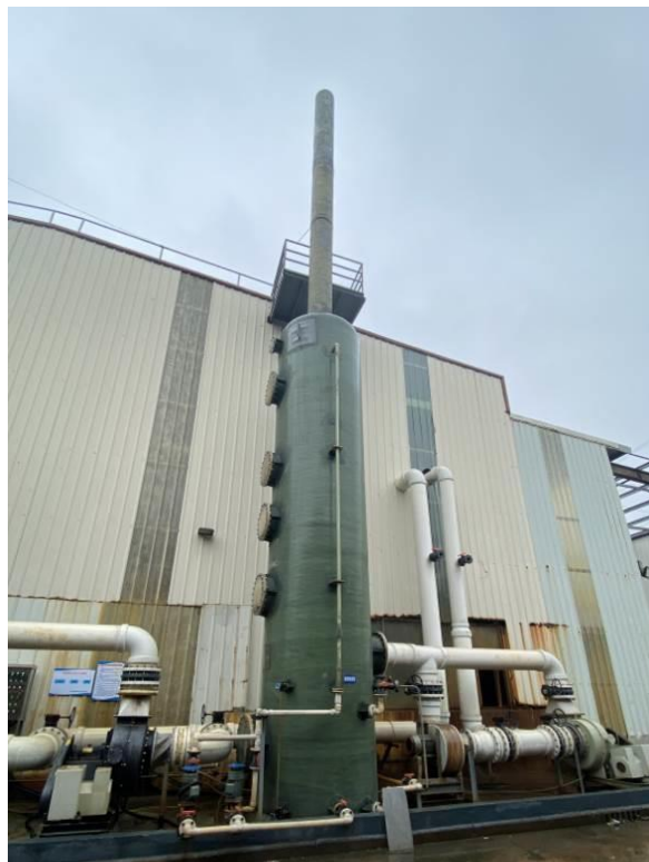
硫酸高铁、胶体制备硫酸雾废气处理设施
